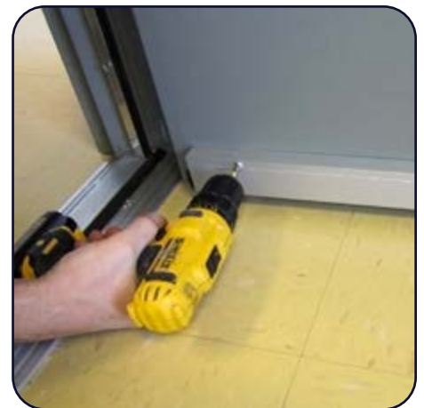
5. Install door bottom.
